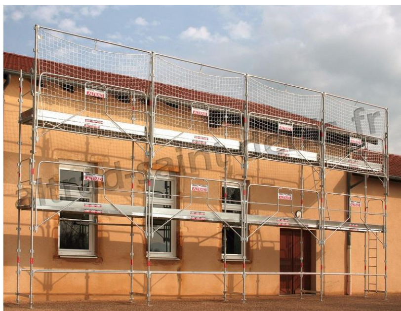
Échafaudage de Pieds avec garde-corps et filet de protection
