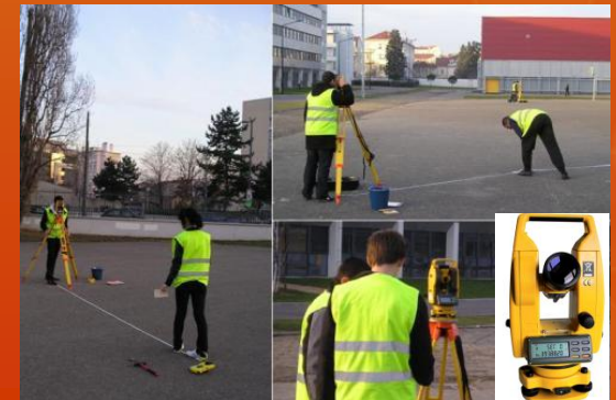
Implanter en planimétrie un ouvrage
